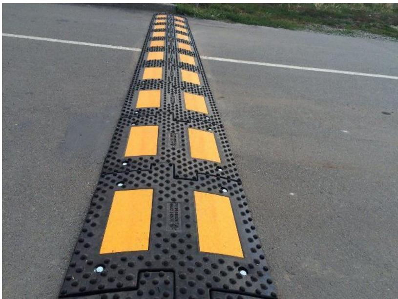
Рис. 2.5.2 – Пример исполнения искусственной неровности сборно-разборной конструкции.
